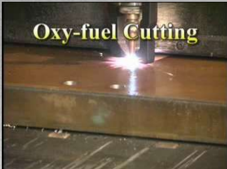
Oxicorte , corte perfectamente cto a 90° Hasta espesor 80 mm. (Un rascador inferior elimina las rebabas).
